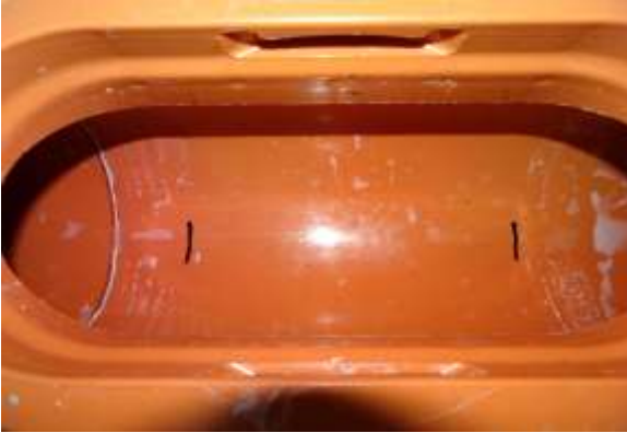
mit Stift die richtige Lage der Klappen anzeichnen
