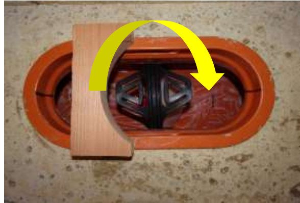
Klappe um 90° drehen und Einbauhilfe richten - Klappe muss in Fließrichtung öffnen
