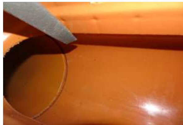
Ablagerungen und Grate mit Feile auf dem gesamten Umfang entfernen
