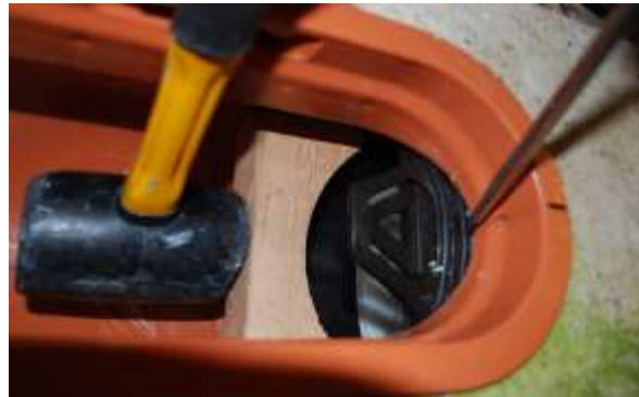
bei Bedarf schwarze Dichtung vorsichtig mit Flachschaubenzieher hinunterdrücken
