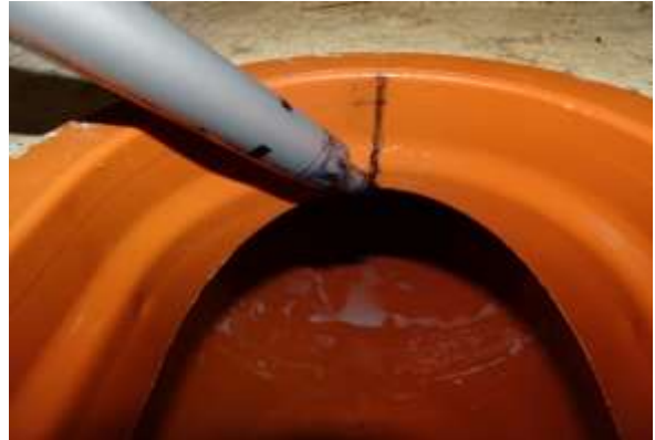
Symmetrieachse vorne und hinten ebenfalls markieren
