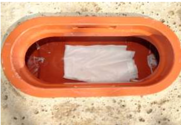
gegebenenfalls mit feiner Stahlwolle und/oder Tuch reinigen
