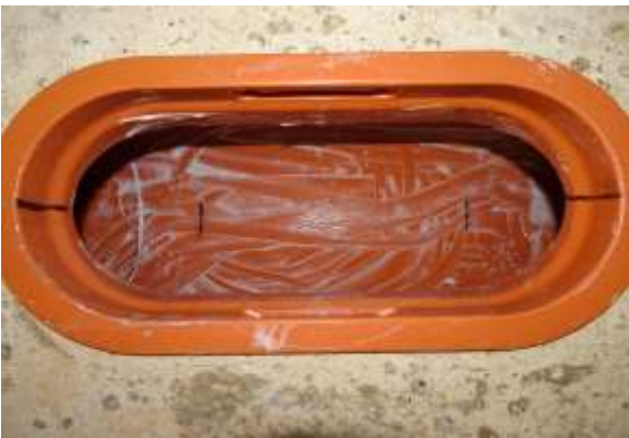
Putzöffnung innen vollflächig mit beigelegten Gleitmittel bestreichen
