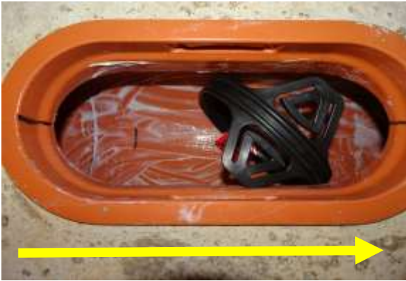
erste Klappe SCHWARZ mit schwarzen Dichtringen einführen
