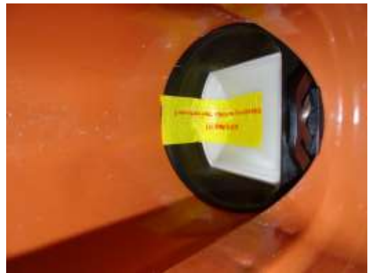
Montagklebeband für 1. Klappe entfernen
