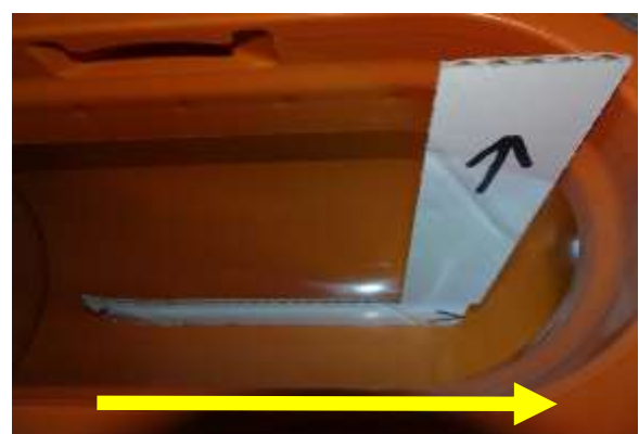
Montagewinkel in Putzöffnung einführen
